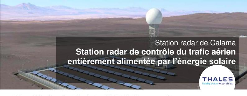
Thales va déployer la première station radar de contrôle du trafic aérien au monde entièrement alimentée par l'énergie solaire à Calama, au Chili. Ce système exploitera 330 panneaux solaires et tirera pleinement partie du fort ensoleillement de la région. Cette station radar solaire se compose d'un radar primaire avancé et d'un radar secondaire.
